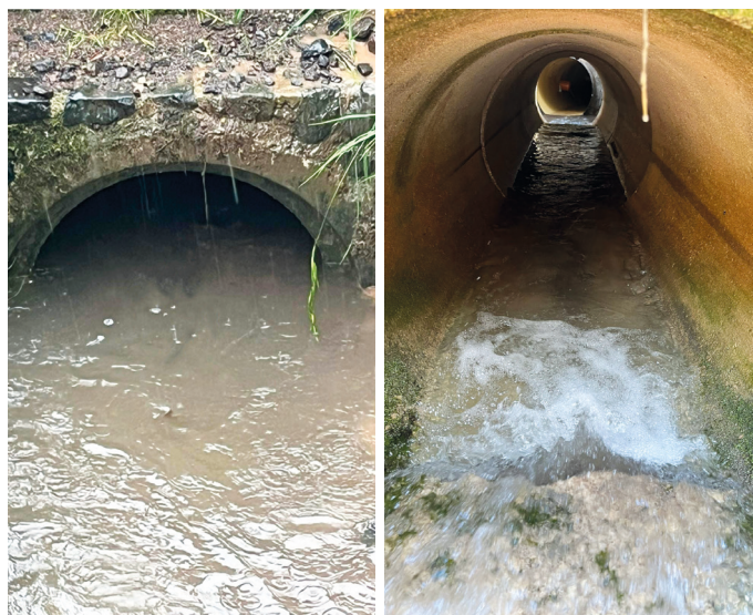
Prima e dopo l'intervento
